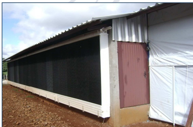
Figura 28 – “Dog House” em sistema de resfriamento por placas evaporativas (Pad Cooling)
