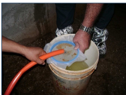
Figura 29 – Após a limpeza do sistema com Evacide, a água eliminada pode conter muita sujeira liberada da tubulação
